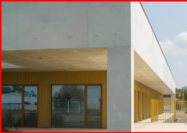
Sur les quatre côtés, les débords de toiture permettent de protéger du soleil les espaces de travail de la cuisine centrale et les salles de restauration, qui peuvent ainsi bénéficier de larges vitrages.
