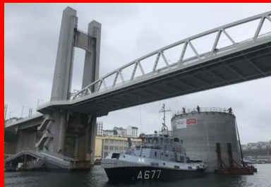
Passage du convoi du musoir sous le célèbre pont de Recouvrance. Afin de pouvoir passer le seuil du bassin n° 4, le musoir a été flanqué de flotteurs additionnels durant le remorquage, ce qui limite son tirant d'eau.
