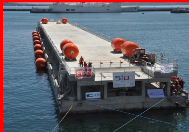
Le ponton flottant dispose de deux ponts superposés. Le pont supérieur est dégagé de toute servitude technique pour rester accessible en permanence aux opérations de chargement/déchargement.
