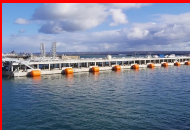
Vue générale du ponton flottant, de la passerelle métallique de liaison au quai (à gauche) et du musoir (à droite), qui constitue le point fixe d'accostage et d'amarrage des frégaes côté mer.
