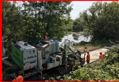
Le nouveau tronçon de la promenade cyclable FI bleu des Berges de l'Orne en cours de réalisation.
