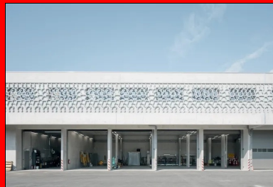
Le bâtiment abrite au rez-de-chaussée les garages, les locaux techniques, les vestiaires. À l'étage sont regroupés les bureaux, une salle de réunion, une cuisine équipée, une salle de repas et de repos.
