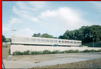
Vue de la façade principale, sur l'avenue Jean Michard Peltissier (D 704). Le mur d'enceinte de la cour sert de protection sonore et visuelle.
