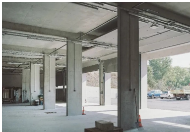
Vue sur le garage des véhicules d'intervention et des engins routiers ouvert sur la cour.
