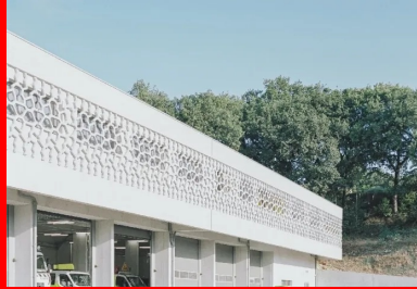
Ce projet est imaginé comme une infrastructure de soutien dialoguant avec les talus, le paysage et l'espace boisé mitoyen.
