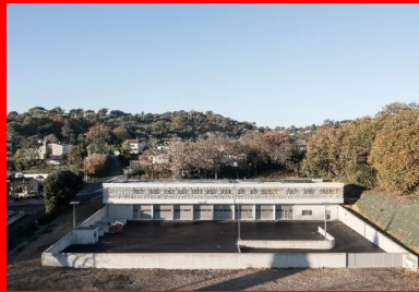
Construit sur un terrain en cuvette présentant une forte déclivité, le projet s'encastre dans la pente.
