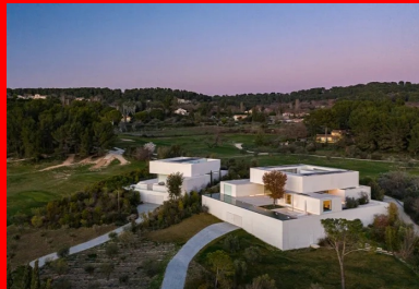
Les volumes en béton blanc des villas émergent de la végétation méditerranéenne.
