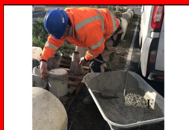
Contrôle qualité du béton frais.
