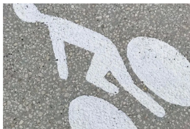
Un des intérêts du béton est de permettre d'imprimer par la méthode du pochoir des dessins durables en surface.
