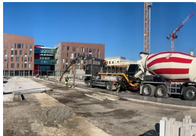
Transport par camion-toupie et livraison du béton à la pompe.
