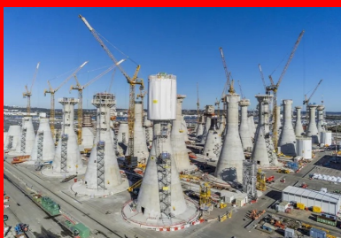
Pour optimiser le processus industriel de construction, les embases étaient réalisées en décalage de phases.
