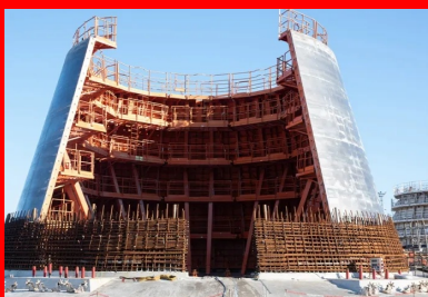
La partie conique du fût était coulée en deux levées successives de 11 m, grâce à des coffrages sur mesure.
