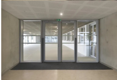
Les halls d'accès aux deux entités scolaires sont reliés entre eux par le préau. © Roland Halbe
