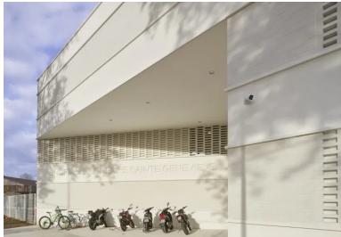
À l'angle, un mur, sur lequel est imprimé en creux le nom de l'établissement, conduit vers l'entrée du collège et du lycée. @ Roland Halbe
