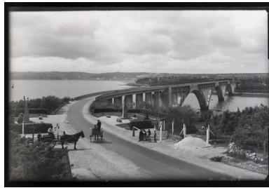
Jusqu'en 1994, année de mise en service du pont voisin de l'Iroise, le pont Albert-Louppe permettait la traversée des voitures automobiles...ou à cheval ! © Coll. Ville de Landerneau ; Photothèque, Association Eugène Freyssinet
