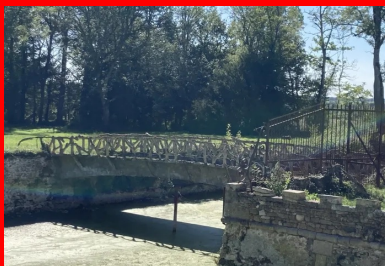
Pont de Chazelet 1
