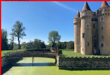
Pont de Chazelet 3
