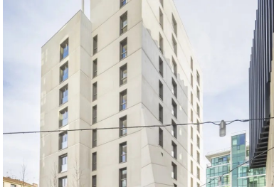
Nichée entre la résidence sociale et le bâtiment de bureaux, la chapelle est accessible par la venelle qui devient parvis.
