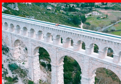
Construit en 1834, cet édifice patrimonial est aujourd'hui l'un des derniers aqueducs en activité.
