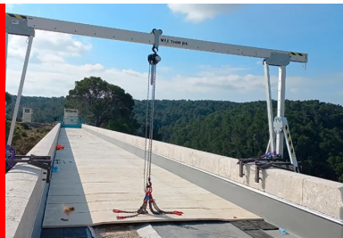
Les dalles manportables sont posées à l'aide d'un portique roulant.
