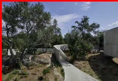
Les courbes de la rampe et du mur d'enceinte se glissent entre les rochers du terrain.
