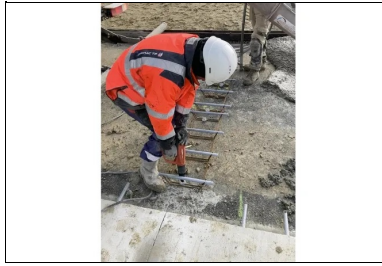
Fixation des paniers de goujons sur la grave-bitume. (© Joseph Abdo_JA-Consulting)
