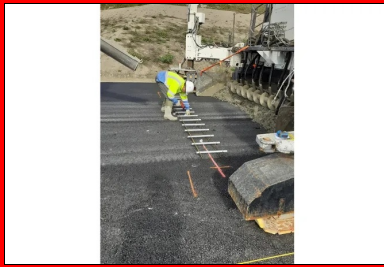
Paniers de goudrons fixés sur la grave-bitume au droit des joints de retrait. (©Eric Sainquantin_DIRA)
