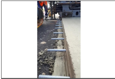
Insertion des goujons à mi-hauteur sur les deux flancs de la bande en béton. (© Luc Lefoll, Eurovia)
