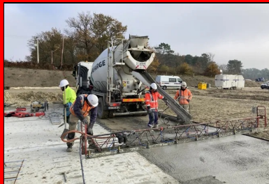
Mise en œuvre manuelle à l'aide d'une aiguille et d'une poutre vibrantes. (© Joseph Abdo_JA-Consulting)
