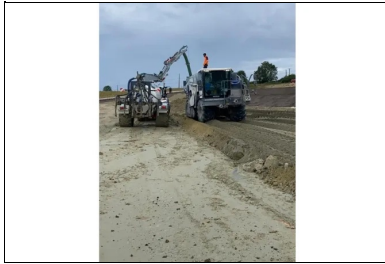
Un malaxage et les derniers ajustements en teneur en eau jusqu'à l'obtention de la teneur optimale se font en injection d'eau directement dans la cloche du pulvimixeur. (© D. Daguzan_Ecostab)
