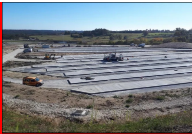
Application de la technique du clivage. Coulage d'une bande sur deux. (© Luc Lefol, Eurovia)
