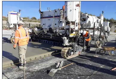
Mise en œuvre mécanisée à l'aide d'une machine à coffrages glissants. (©Eric Sainquantin_DIRA)
