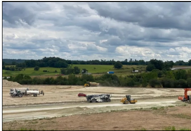
Vue de l'atelier de traitement du sol en place au liant LIGEX avec, au premier plan, un compacteur à bille lisse en action. (© D. Daguzan_Ecostab)
