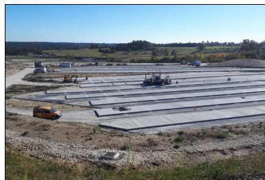
Application de la technique du clavage. Coulage d'une bande sur deux. (© Luc Lefoll_Eurovia)
