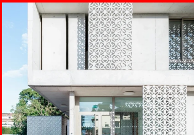
Des dalles en béton brut sont portées par des refends de même nature, rehaussés par les panneaux ajourés qui jouent ici le rôle de protection solaire.
