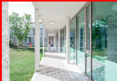
Les différents bâtiments de l'institution sont desservis par des coursives extérieures. Celles-ci sont bordées et ponctuées par les mêmes éléments de panneaux de façade ajourés en béton fibré.
