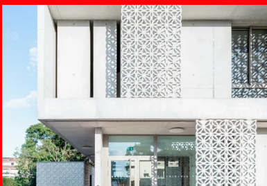
Des dalles en béton brut sont portées par des refends de même nature, rehaussés par les panneaux ajourés qui jouent ici le rôle de protection solaire.
