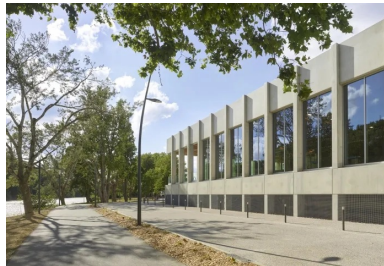
Vue de la façade sud de la halle des bassins. Elle est rythmée par des poteaux porteurs en béton, de 30 cm x 50 cm, espacés selon un pas de trame régulier de 2,55 m et surmontés par une poutre de couronnement, elle aussi en béton. L'ensemble exprime la grille constructive du projet, dessine son enveloppe et lui confère son identité.
