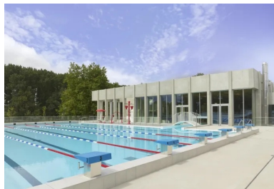
Vue sur le bassin nordique extérieur et sur la halle des bassins.
