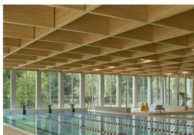
Vue intérieure de la halle des bassins.
