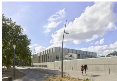
Les accès vers le pôle aqualudique s'organisent le long de cheminements en bordure de l'Aude.
