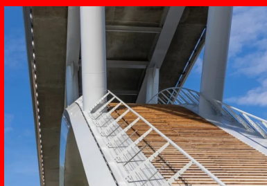
L'extrados de l'arc est utilisé comme une passerelle piétonne. 140 marches en bois de largeur variable sont positionnées sur chacune des pentes de l'arc et donnent accès à une plateforme belvédère située à la clé, à 25 mètres au-dessus de la Mayenne. © Xavier BOYMOND
