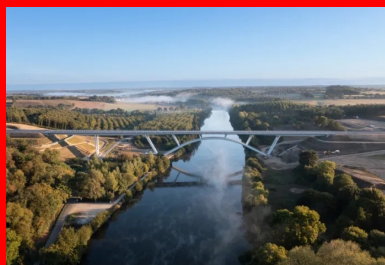
Situé à quinze minutes à pied du centre-ville de Château-Gontier, le viaduc de la Mayenne est l'ouvrage majeur du contournement routier nord de la sous-préfecture de la Mayenne. Son arc structurel de 122 mètres de portée enjambe majestueusement la rivière. © Xavier BOYMOND
