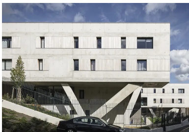
Le soulèvement d'une partie de la barrette de logements par des poteaux obliques allège la masse bâtie.
