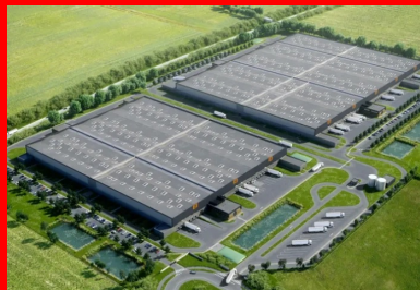
Vue d'artiste du nouveau parc logistique Logisterra, dont la livraison est prévue au troisième trimestre 2023. Achevé, le bâtiment principal aura une superficie de 102 000 m 2 .
