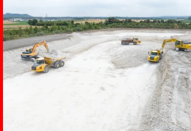
Reprise sur stock à l'aide d'une pelle sur chenilles et de tombereaux articulés. (© Colas)
