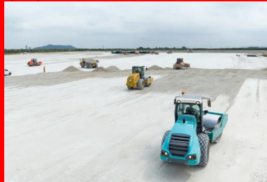
Acheminement de la craie et mise en œuvre de celle-ci en couches de 40 cm et 50 cm. (© Colas)
