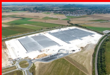
Vue générale de la plate-forme support traitée au ROC VDS et achevée, prête à recevoir les bâtiments, les aménagements extérieurs et les voiries. (© Colas/ArtoisDrones)
