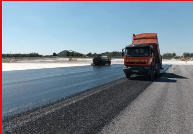
Enduit bicouche clouté qui assure la protection de la couche de forme traitée. (© Colas)
