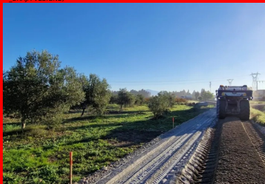
La malaxeur moderne Wirtgen WR 240 mélange le liant LVTS 13 avec le sol intimement sur une épaisseur foisonnée de 35 cm. (© B. Montagnini _Ecostab)
