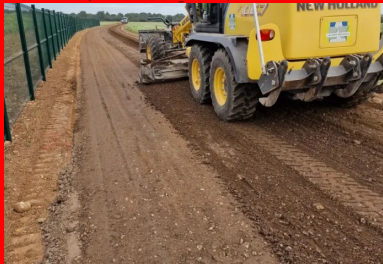
REGLAGE FIN DE LA PLATE-FORME TRAITÉE A L'AIDE D'UNE NIVELEUSE. (© B. MONTAGNINI _ECOSTAB)
