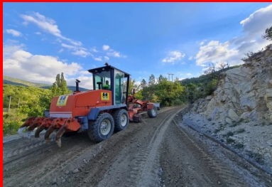
Le pré-réglage du matériau traité à l'aide d'une niveleuse, avant le compactage. (© B. MONTAGNINI _ECOSTAB)
