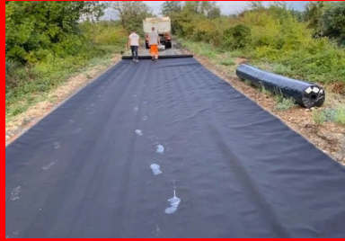
Mise en place d'un géotextile sur l'ensemble de la plate-forme. (© Jacob Gouvenaux_Braja Vésigné)
