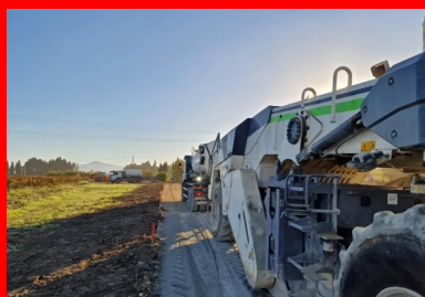
Le traitement des matériaux du site avec un liant hydraulique routier est une technique incontournable dans le cas d'aménagement d'une voie étroite. (© Bruno Montagrin, Ecotab)
