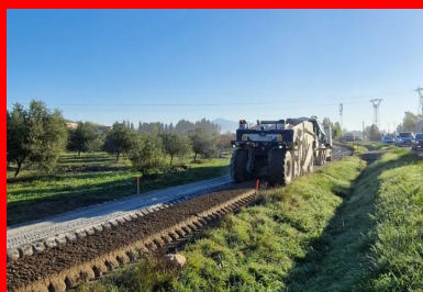
La voie verte Via Venaissia sur le tronçon entre Jonquières et Orange. (© Bruno Montagrim, Ecostab)
