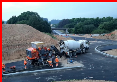
Après la mise en œuvre de la grave-bitume, une machine à coffrage glissant a réalisé les bordures et les bordures-caniveaux. (© Quentin Hognon, Colas)
