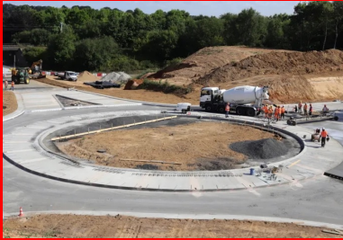
Bétonnage de l'anneau extérieur du carrefour giratoire. (© Quentin Hognon, Colas)
