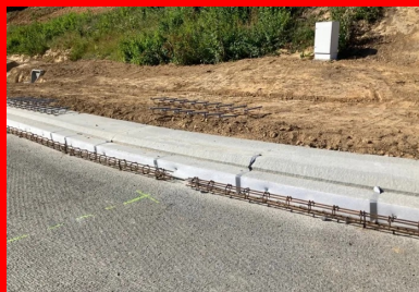
Les chaînages ont été mis en place pour renforcer les bords de dalles sollicités ainsi qu'au droit des joints de dilatation. (© Quentin Hognon, Colas)
