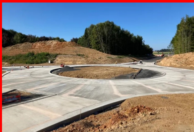
Vue du carrefour giratoire en béton en cours de finition. (© Joseph Abdo, JA-Consulting)
