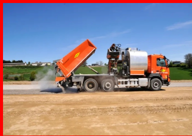
Protection de la couche de forme.
