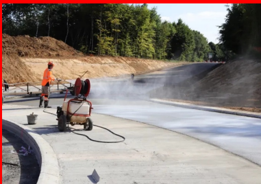
Pulvérisation d'un produit de cure à la surface du béton. (© Quentin Hognon, Colas)
