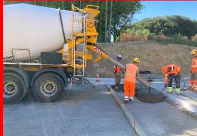
Réalisation de la dalle de transition. (© Joseph Abdo, JA-Consulting)
