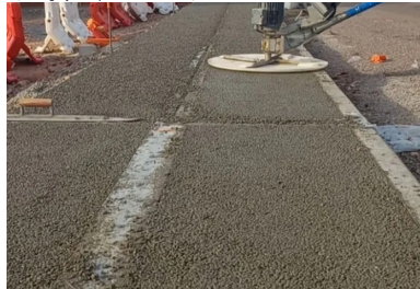
Après le passage du rouleau lesté, le béton est lissé à l'aide d'un outil spécifique. (©Grégory Charpenet, Béton Vicat).
