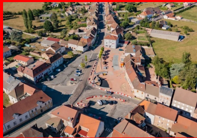
Vue de la place du Champ-de-Foire pendant les travaux. (©Jean-Sébastien Deborde, Ingepro).
