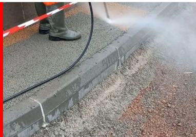
Dans un délai de 24 heures après le coulage, le béton est lavé au surpresseur. (© Gregory Charpenet, Béton Vicat)
