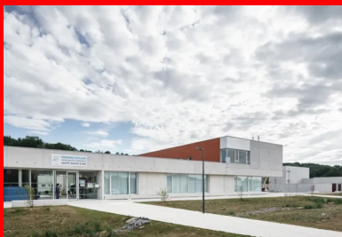
Vue de l'école et du centre diocésain sur la rue des Sables.
