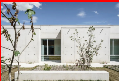
Vue du couloir des classes maternelles depuis le patio.
