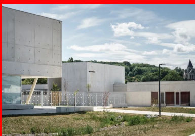
L'entrée de l'école élémentaire se situe à l'angle nord-ouest du bâtiment sous l'avancée du volume du premier niveau. En second plan le centre diocésain est dominé par le parallélépipède rectangle en béton brut de la chapelle.
