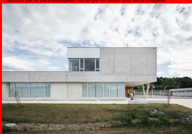
L'avancée du volume du premier niveau est portée par 2 poteaux en béton, inclinés en V, qui signalent la séquence d'entrée de l'école élémentaire.
