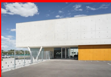
Le hall de l'école élémentaire se développe transversalement à la séquence d'entrée et offre en transparence une vue sur le patio central.
