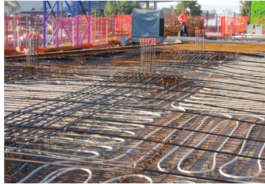
Pavillon 52 - Lyon Confluences. Intégrant avant coulage un échangeur thermique alimenté par la nappe phréatique (tubes blancs sur la photo), les planchers précontraints assurent le chauffage-rafraîchissement de l'immeuble. L'absence de poutres garantit une distribution thermique uniforme sur toute la surface. © FREYSSINET
