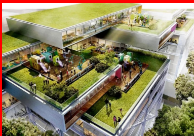
Hôpital Mater - Dublin (Irlande). En dégagant de vastes plateaux, les planchers précontraints par post-tension permettent une grande flexibilité dans l'aménagement intérieur. Cette flexibilité est particulièrement précieuse dans les hôpitaux, où l'espace peut devoir être réaménagé pour répondre à de nouvelles exigences ou technologies médicales. Par ailleurs, la grande capacité portante de ces planchers leur permet de supporter facilement de lourds équipements médicaux (scanners, équipements de radiologie...). © NBB Architects
