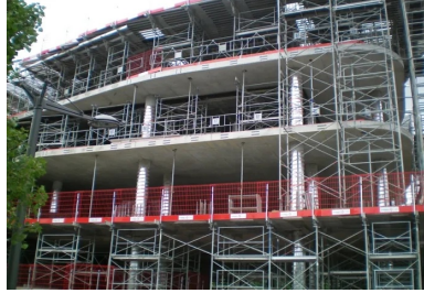
Pavillon 52 - Lyon Confluences. Coulés en place, les planchers précontraints par post-tension disposent d'une souplesse de mise en œuvre qui s'adapte aux courbes irrégulières des différents niveaux. © FREYSSINET
