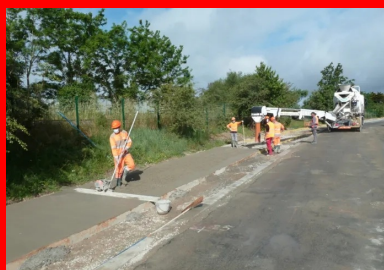
Mise en œuvre manuelle du béton, livré par camion-toupie équipé de tapis. (©CIBéton)
