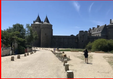
L'avant du château de Suscinio, le belvédère après les travaux d'aménagement. (© Phytolab)
