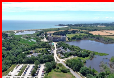
Vue aérienne des aménagements des espaces publics autour du château de Suscinio. (© Phytolab)
