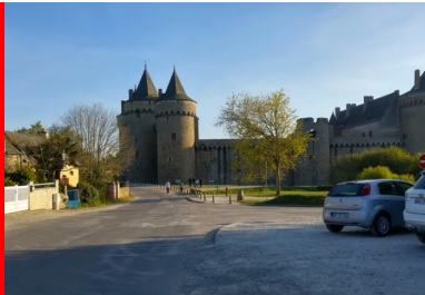
L'avant du château de Suscinio, le belvédère avant les travaux d'aménagement. (© Phytolab)
