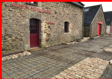
Après avoir réalisé les coffrages et le pavage, le treillis soudé est positionné sur des cales au tiers inférieur du revêtement en béton. (©Phytolab)
