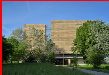
Entrée nord, côté campus. La césure vitrée verticale correspond à la rue intérieure.
