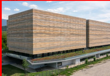
Façade ouest. La « casquette » offre un premier plan végétal aux bureaux situés au premier étage.
