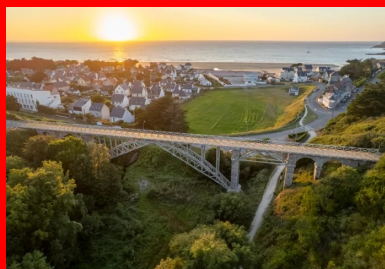
D'une longueur totale de 109,25 m, le viaduc de Caroual, situé à Erquy (22), comprend un arc central de 45 m de portée en béton armé. Il a été restauré en 2021. (© Pierrick Menard)
