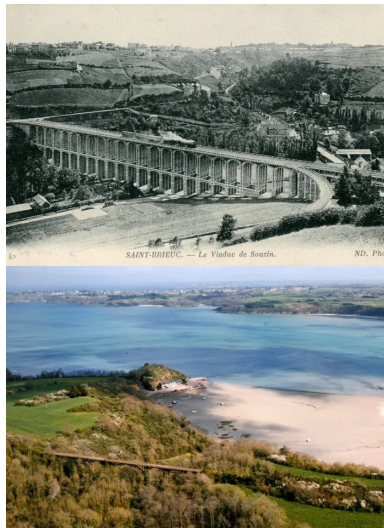
Construit à Saint-Brieuc en 1904, le viaduc de Souzain était un ouvrage complexe en trois parties : un ouvrage d'accès, un ouvrage principal et une dérivation. D'une longueur totale de 274 m pour une hauteur de 35 m et une largeur de 11,40 m, il a été détruit le 27 juin 1995. (© DR)
