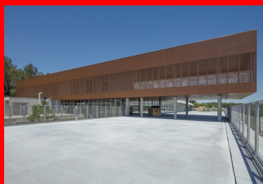
Dans la cour principale, l'étage supérieur en porte-à-faux dessine un préau naturel.
