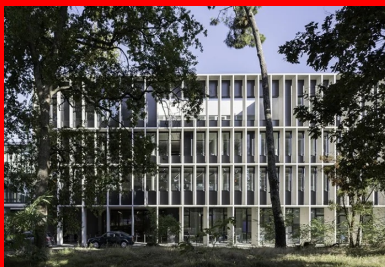
Côté sud, le long de la ligne de tramway, la résille de béton qui protège la façade affiche une profondeur de 80 cm.
