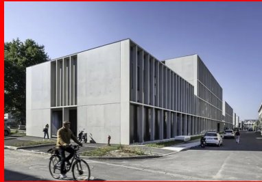
L'implantation du bâtiment H recrée une rue en s'inscrivant dans le plan original du campus.
