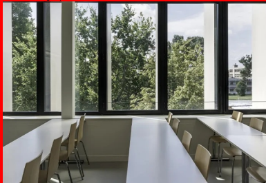
La rislille extérieure en béton protège sans refermer, ni entraver les vues.
