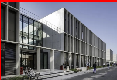
Côté nord, la résille de béton d'une épaisseur de 40 cm s'adapte à l'orientation et s'amincit.
