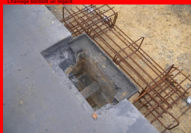
Chaînage autour d'un avaloir.
