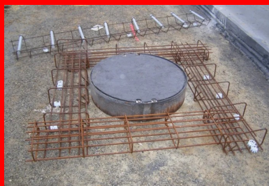
Chaînage bordant un regard.
