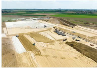
Vue générale des travaux de terrassement de la plate-forme logistique d'Illies et de Salomé. (©Celas)
