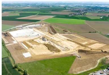
Vue générale du chantier de terrassement. (©Colas)
