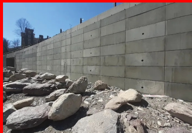
Mur poids en écailles préfabriquées pour la brèche n° 19.
