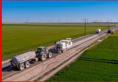
Photo 2 : chantier de retraitement des chaussées en place à froid aux lants hydrauliques routiers (c) CIMbéton
