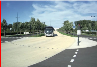
Photo 5 : Plate-forme en béton pour Bus à Haut Niveau de Service BHNS, Melun-Sénart (c) CIMbéton
