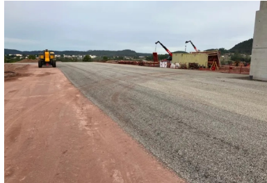
Enduit de cure pour protéger le sol traité. (© Scierie-Gaiffe et Avinim Construction)
