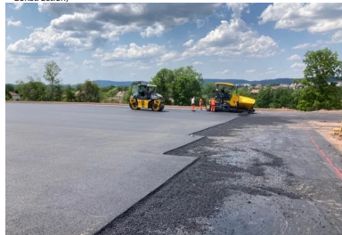
Mise en œuvre de la couche de surface en BBSG. (© Scierie-Gaiffe et Avinim Construction)
