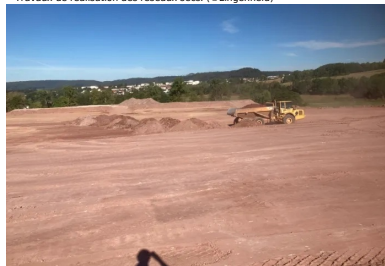
Mouvement de terre. Le matériau est acheminé et mis en place en couches d'épaisseur variable en fonction de la zone, afin de conférer à la plate-forme les caractéristiques topographiques visées. (© Scierie-Gaiffe et Avinim Construction)
