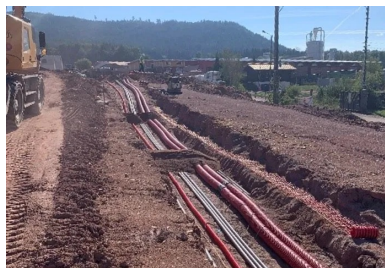
Travaux de réalisation des réseaux secs. (©Lingenheld)
