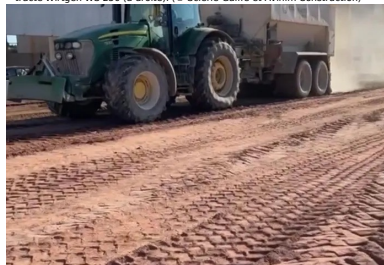
Épandage du liant avec précision à l'aide d'un épandeur tracté Streamaster. (© SARL Alan Brunner)
