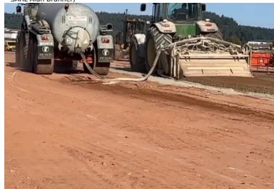
Le malaxeur tracté Wirtgen W5 250 mélange intimement le sol, le liant et l'eau introduite directement dans la cloche du malaxeur (© SARL Alan Brunner)
