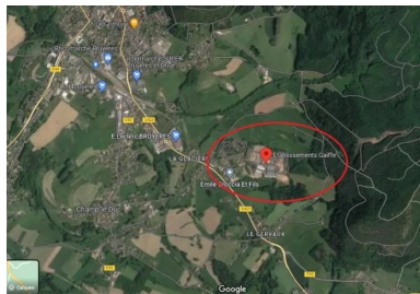
Plan de situation de la scierie Gaiffe sur la commune de Champ-le-Duc (88).
