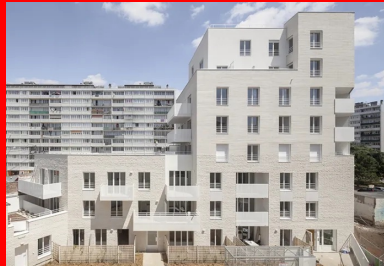
L'élévation progressive du bâti, depuis les pavillons mitoyens jusqu'à la rue, est soulignée par la finition des briques de béton qui habillent les façades, rugueuse en soulèvement et lisse sur les étages.
