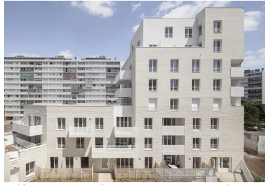
L'élévation progressive du bâti, depuis les pavillons mitoyens jusqu'à la rue, est soulignée par la finition des briques de béton qui habillent les façades, rugueuse en soubassement et lisse sur les étages.
