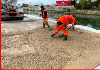
Le béton est tiré à l'aide d'un râteau. (© Sébastien Vinatier/Sols)
