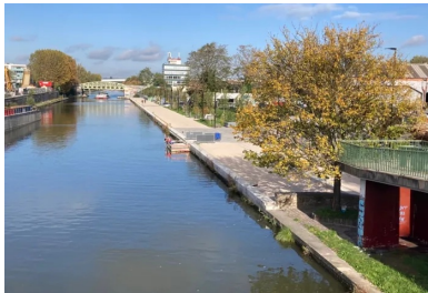
Les berges du canal Saint-Denis à Aubervilliers, aménagées en béton sablé. (©Joseph AbdoJA-Consulting)
