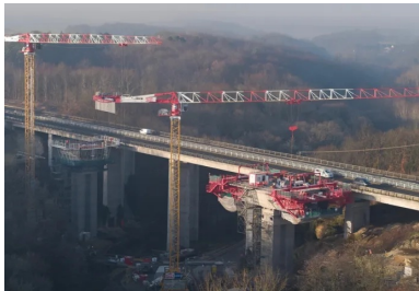
Afin d'éviter tout déséquilibre de la structure, les voussoirs sont construits en encorbellement, symétriquement de part et d'autre de chaque pile.
