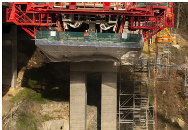
Les voussoirs sont coulés au sein de coffrages spécifiques appelés équipages mobiles. Ils se déplacent de manière symétrique au fur et à mesure des bétonnages.
