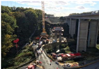
Les nombreuses contraintes d'accessibilité au fond de cette vallée encaissée ont conduit à réaliser une déviation et un pont provisoires ainsi qu'une paroi de soutènement clouée...
