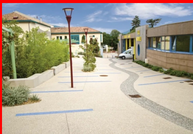
Aménagement urbain en béton coloré et désactivé.
