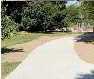
Allée en béton drainant - Au fond Aire de jeux en béton drainant.
