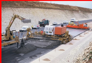
Mise en œuvre à la machine à coffrages glissants d'une structure composée en Béton Armé Continu B4C sur Grove Bitume G83, RN 141 ; Déviation des Rassaats-Favrauds.
