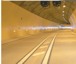
Tunnel en béton.
