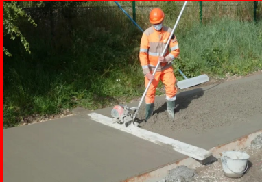
Mise en œuvre du béton manuellement.
