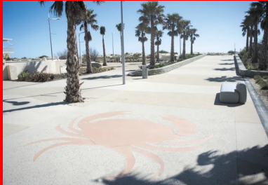
Aménagement en béton imprimé, en béton incrusté et en béton désactivé.
