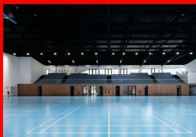
Gymnase - Une nappe structurelle faite de six poutres métalliques en treillis, peintes en noir, permet de franchir les 45 m de portée libre.
