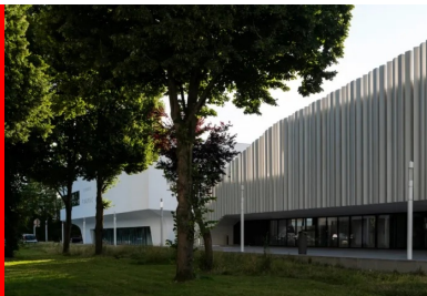
Gymnase et MSP – Implantés en alignement, les deux équipements sont bordés par un parvis public piétonnier qui permet de traverser la parcelle de rue à rue.
