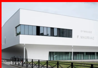
Gymnase François-Mauriac - Le gymnase semble découpé dans son épaisseur pour générer des auvents protecteurs et apporter de la lumière naturelle dans chacune des salles.
