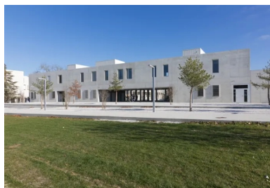
Le bâtiment enseignement vu de puis le « campo central ».
