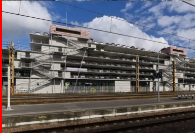
Seuls éléments pittoresques, les émergences en toiture des circulations, parées de marbre rose et baptisées carrelets.
