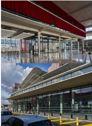
dans la continuité du hall, l'espace d'attente et d'accueil se glisse sous le premier niveau partiel de parking perceptible derrière les rideaux rouges.
