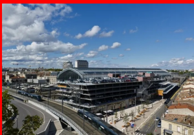
Le béton de ciment clair laissé apparent s'accorde à la pierre blonde du bâti alentour.
