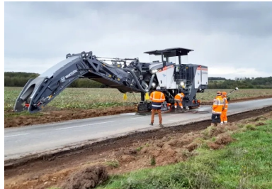
Fragmentation de l'ancienne chaussée sur 15 cm et régalaé du matériau décohesionné sur toute la largeur de la nouvelle plate-forme de chaussée. (©Ludovic Padeloup/Conseil départemental de la Vienne)
