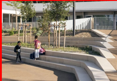
Un aménagement en gradins qui permet de gérer la pente naturelle du terrain anime la cour.
