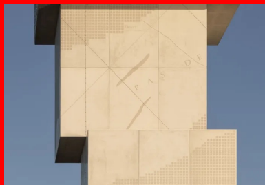
Les façades en pré-mur béton recroquent l'identité calaisienne par des inscriptions dans la matière.
