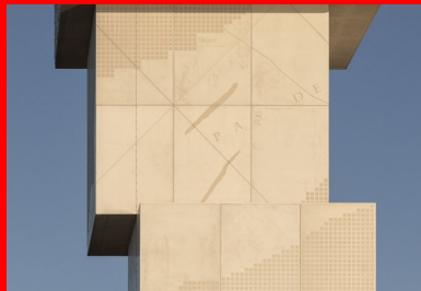
Les façades en précontraint béton recroquent l'identité calaisienne par des inscriptions dans la matière.
