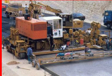
Mise en oeuvre du béton à l'aide d'une machine à coffrages glissants.
