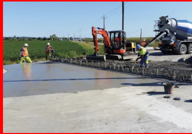
Mise en oeuvre du béton à la poutre vibrante.
