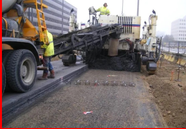
Chaussée composite BC5g/GB3
