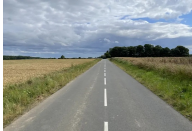
Réhabilitation de la RD119 achevée. Accotements rehaussés et signalisation horizontale réalisée. (© Fenêtre sur cour)
