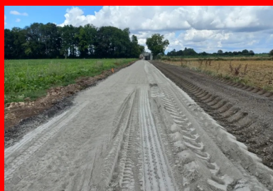
Épandage du liant ROC VDS à la surface des fraisats d'enrobé à l'aide de l'épandeur Streumaster SW18CI (LTV 333). (©Colas)
