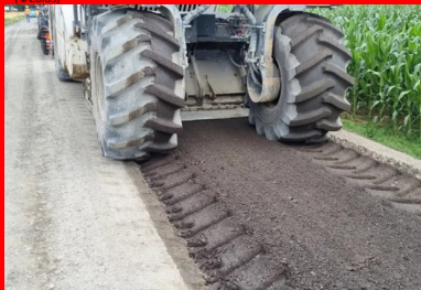
Section 2, Atelier de retraitement partiel à l'émulsion de bitume du matériau déjà retraité au liant ROC VDS. (©Colas)
