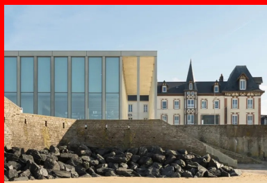
Façade nord en lien direct avec la mer.
