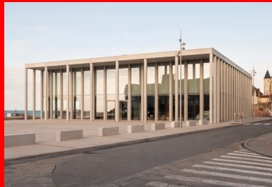
La position centrale de l'exosquelette de béton définit les deux espaces publics du grand parvis en béton sablé couleur sable micro-désactivé et du jardin qui longe la cale à l'arrière.
