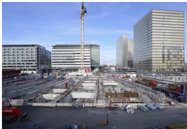
Intégration du projet dans son milieu urbain.
