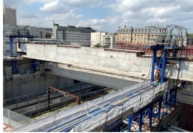
Des portiques de levage situés de part et d'autre de la méga-poutre permettent de descendre celle-ci jusqu'à sa position définitive, par l'intermédiaire de chevêtres brisés à la structure par des barres précontraintes.
