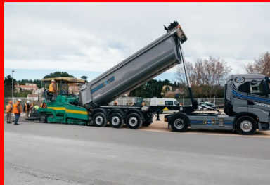
Un camion-benne, bâché durant le transport du BCR, déverse le matériau dans le finisseur. Celui-ci répand, nivelle et compacte le BCR. (©Colas)
