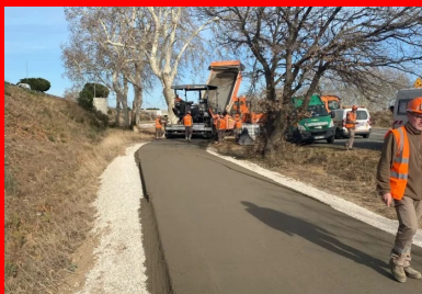
Piste cyclable en BCR en cours de réalisation. (©Colas)
